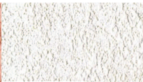
Obr. 3 Zatíraná omítka
