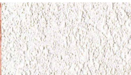
Obr. 3 Zatíraná omítka
